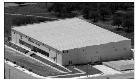
MONTERREY, NUEVO LEÓN, MÉXICO
